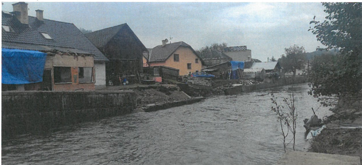
FOTO 9 – poškozená LB zeď v obci Bohdíkov, ř. km 304,95
