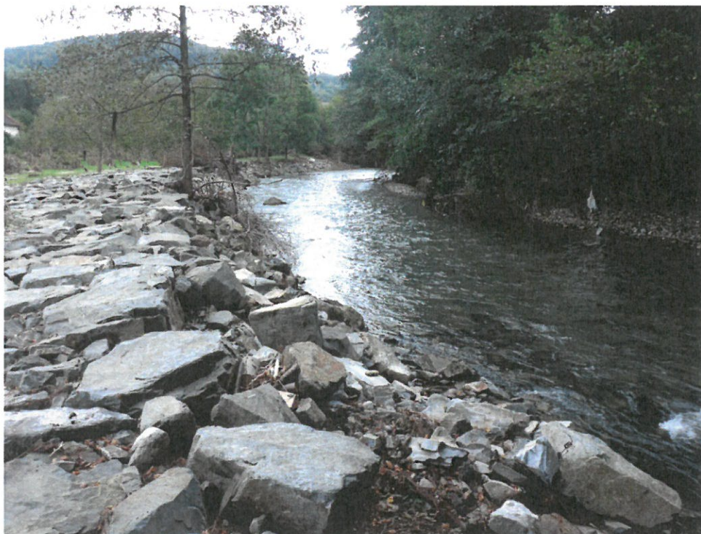
FOTO 7 – LB nátrž kolem odlehčovacího prahu v místě jezu u Alojzovských papíren, ř. km 301,050
