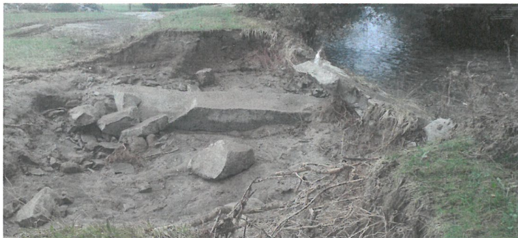
FOTO 4 – LB nátrž zasahující pod nemovitost, ř. km 298,150
